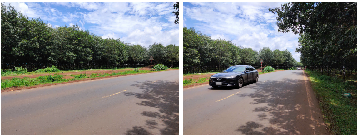
Hiện trạng giao thông khu vực dự án
