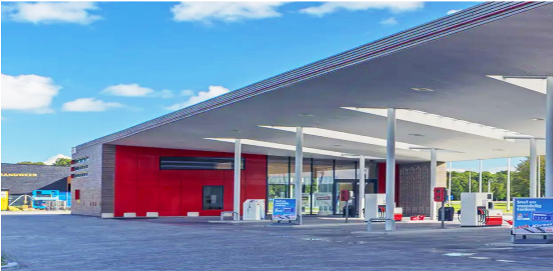
Trạm xăng dầu
